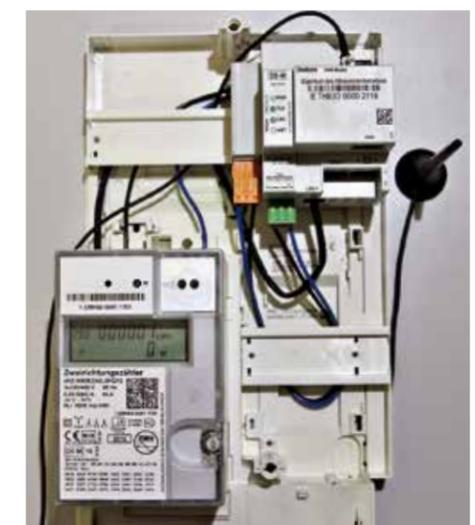
den bevorstehenden Rollout der „Smart Meter“ vorbereitet. Bei mehr als 10% der Stromkunden in Vilsbiburg sind bereits digitale Zähler installiert. Sobald ausreichend viele Gateways zur Verfügung stehen, kann die Aufrüstung zum intelligenten Messsystem erfolgen. Aktuell testen die Stadtwerke auf Ihrem Betriebsgelände erste Gateways auf Herz und Nieren und bereiten die EDV-Systeme auf die neuen Aufgaben vor.
