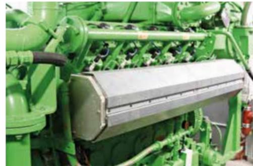
12-Zylinder-Gasmotor zur Deckung von Stromspitzen
