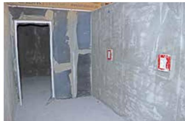
Die Verputzarbeiten am Sanitärbereich sind weitgehend abgeschlossen. Rechts: Ein Teil der Sanitärbereiche wird für Umkleiden und Duschen mit einer wärmeisolierten Decke ausgestattet. Dieser kann dann bei kühler Witterung mit elektrischen Heizlüftern beheizt werden.
