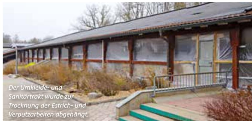
Der Umkleide- und Sanitärtrakt wurde zur Trocknung der Estrich- und Verputzarbeiten abgehängt.
